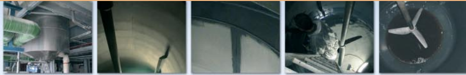
Mechanisch verwijderen van geroeste delen en drogen van binnenste oppervlak
